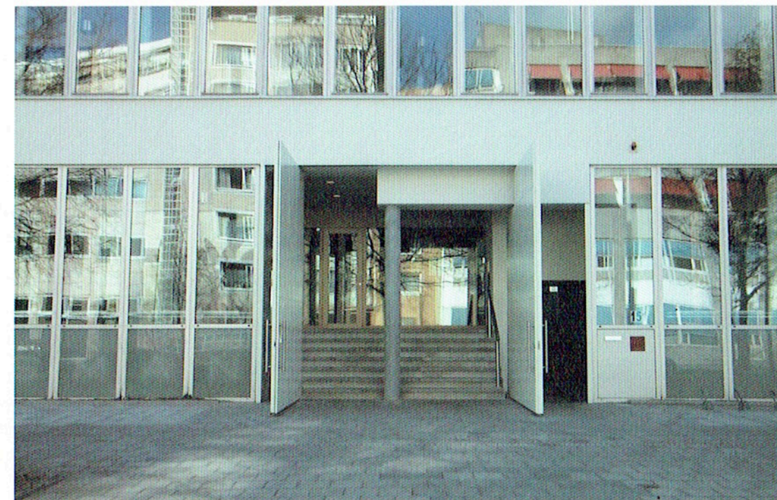
De pivoterende deuren van de entree. foto Jules van Vark
